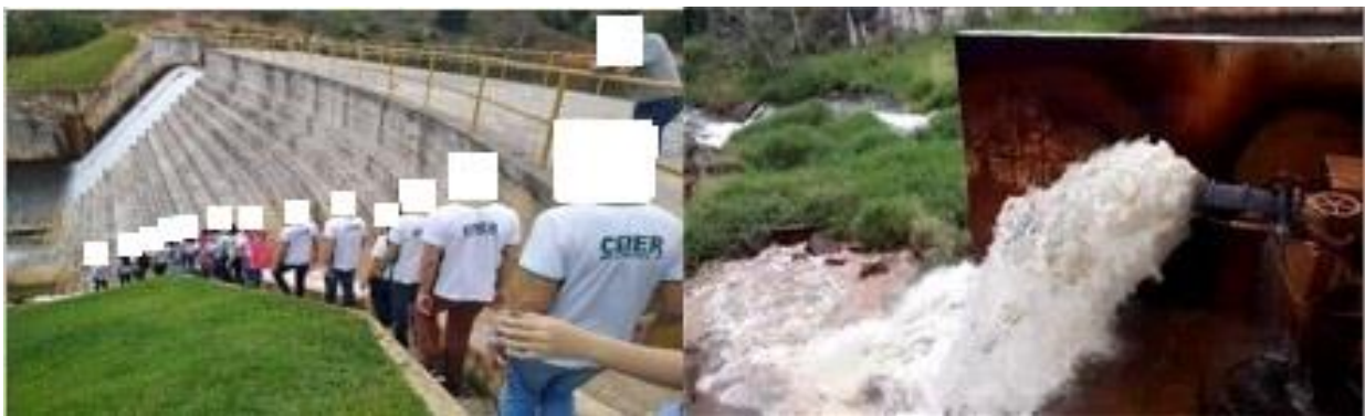
Figura 4 - Descida a casa de máquina ao lado, fotografia do dispositivo de controle da comporta reguladora do volume represado.
