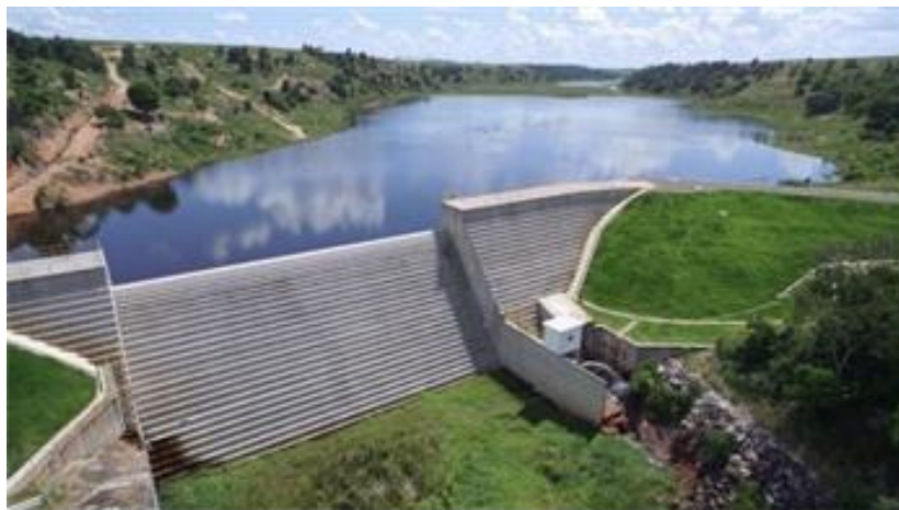
Figura 1 - Barragem Engenheiro Valter José Matielo.
